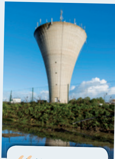
« Le château d'eau de Plérin. »
