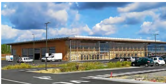
Le nouveau dépôt des bus a été inauguré le 8 septembre 2019.
